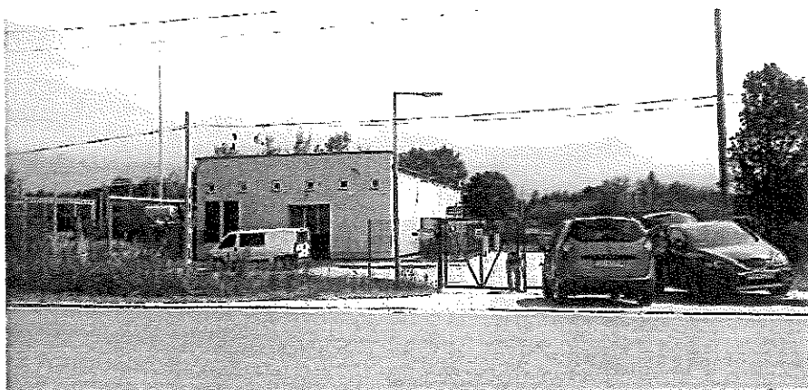
Podstacja trakcyjna 110/15/3 kV PT Bartodzieje – brama wjazdowa
