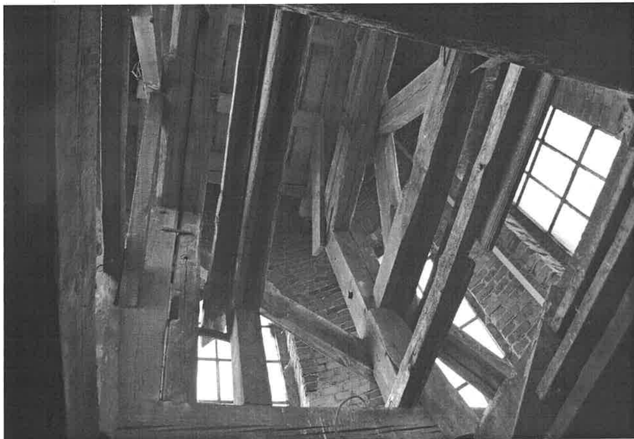
29. Konstrukcja drewniana pod dzwony.
