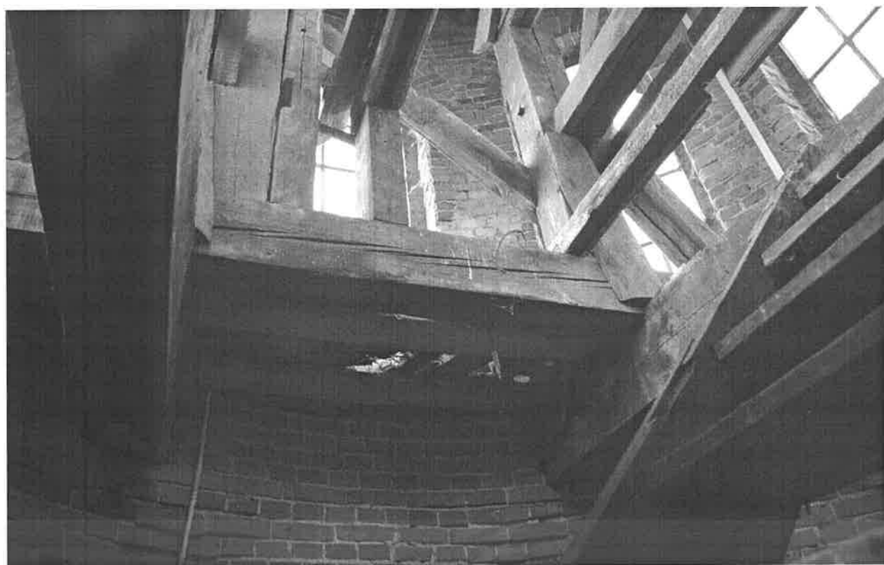
30. Konstrukcja drewniana pod dzwony.
