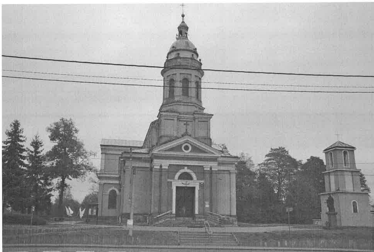
1. Widok ogólny – elewacja frontowa południowo-zachodnia.
